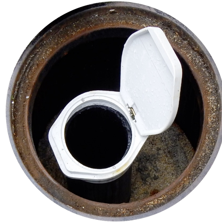
Blick in eine fertiggestellte Grundwassermessstelle
